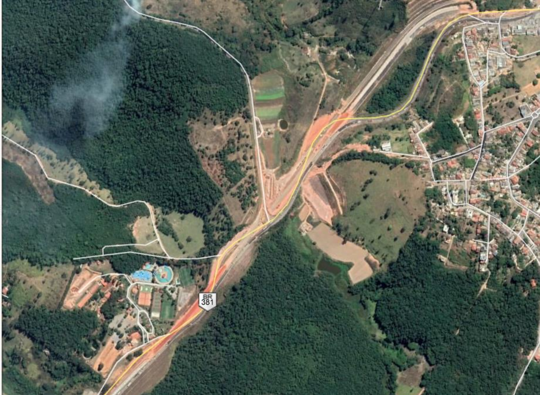
OBRA DE DUPLICAÇÃO DA BR-381 EM TAQUARAÇU DE MINAS
